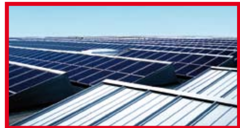
Fase di montaggio dei moduli su ISI Fit.
