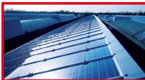
Particolare dell'impianto completato.
