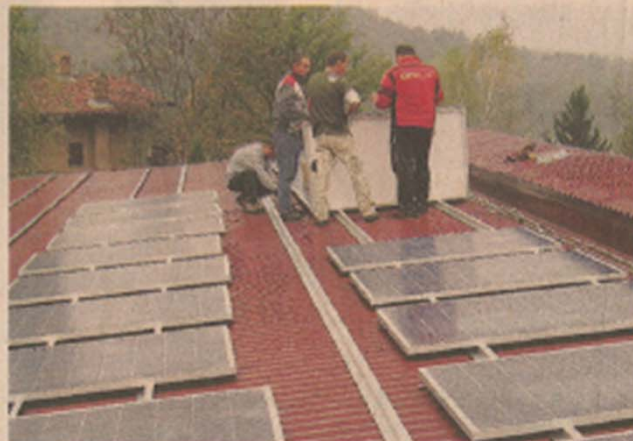
Tutti all'opera. Un momento dell'installazione dei pannelli solari sul tetto nella cittadella dello spirito di Bose, sulla serra morenica di Ivrea
